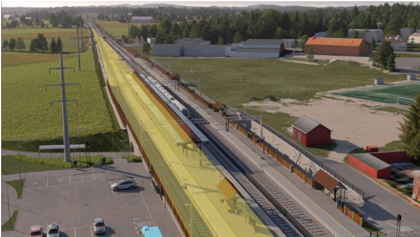
Figur 8 Oversiktsbilde fra stasjonsområde mot nordvest, retning Moss. Gul skygge markerer omtrentlig avgrensning av utvidelsen av spor- og plattformområde.
